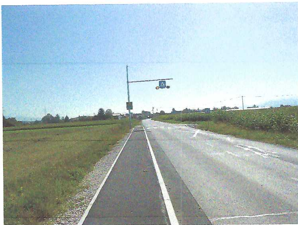
Fotografija št. 1: Pločnik in označen ter osvetljen prehod za pešce čez cesto Žalec - Velika Pirešica
