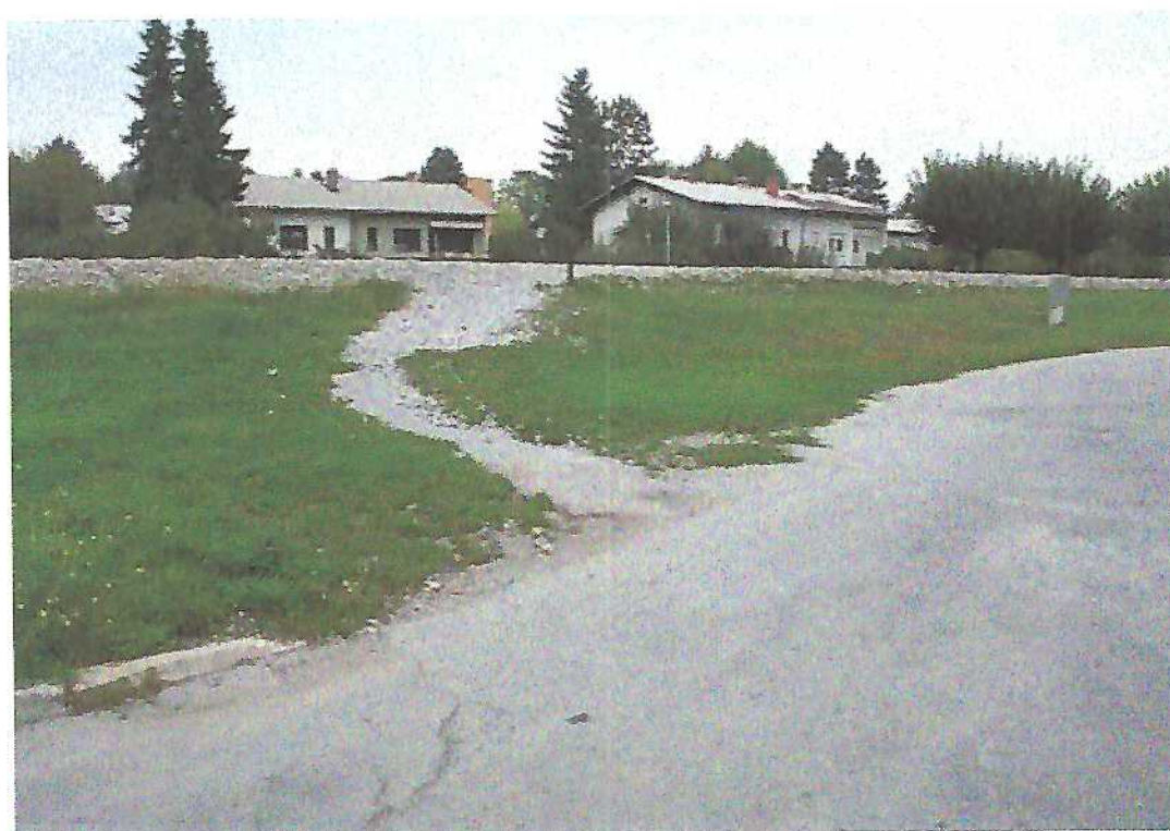
Fotografija št.8: Vrbje - nezavarovan prehod čez železniško progo
